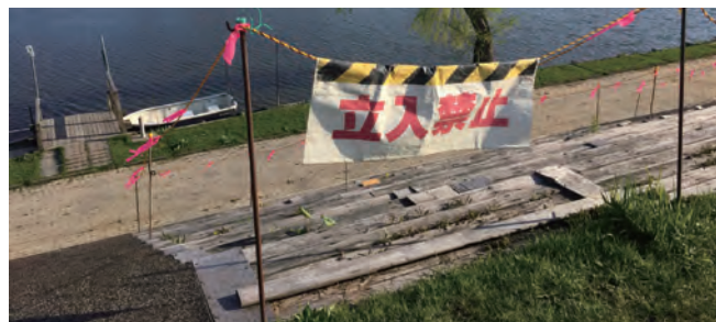
皆楽公園メイン階段。朽ちて壊れ、立入禁止のロープが張られている。審議会では皆楽公園の整備方針も決定するとのこと。修繕費用不明の中で判断するのは難しいと思う。
